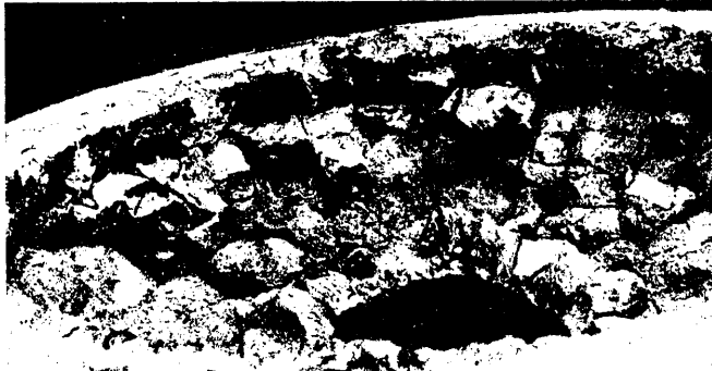
Abb. 6 Abgeplatzte Decke eines Feuerraums. Ursache: Ungenügende Temperaturwechsel- und Raumbeständigkeit der verwendeten Steine
