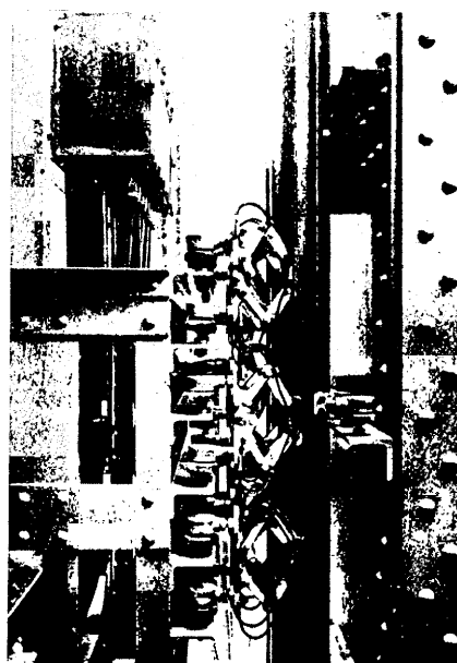
Die Schleifleitungseinrichtung zum Übertragen des Betriebsstromes auf den fahrbaren Schiffstrog im Schiffshebewerk Rothensee. Die Schleifschiene (rechts) liegen am feststehenden Hebewerkteil, die Stromabnehmer am Schiffstrog (Werkaufnahmen: Siemens)
