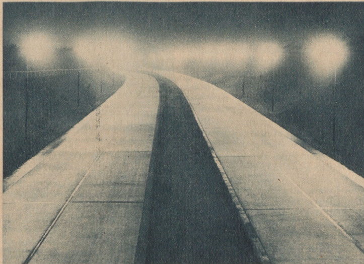
Abb. 4 Zufahrtstraße zur Reichsautobahn bei Hamburg. Beleuchtet mit Zweiwalspiegel-Mischlichtleuchten (Werkaufnahmen: Zeiss-Ikon)
