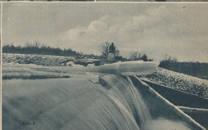
Abb. 3 Fertiggestelltes Wehr, Unterwasserseite vor der Inbetriebnahme (Aufnahme: Fentzloff)
