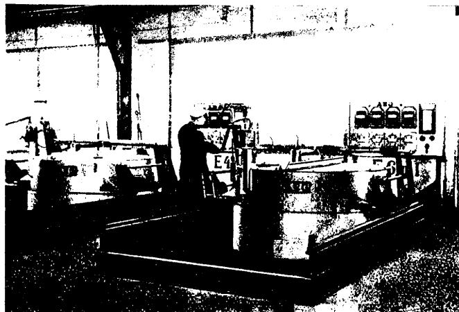
Abb. 11 Elektrisch beheizter Schachtofen für 950° C. Anschlußwert 500 kW
