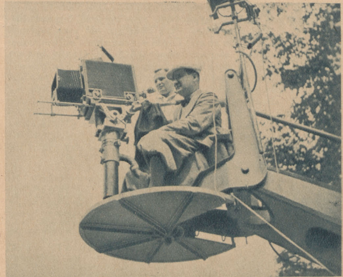
Abb. 7 Plattform des Fahrkrans mit der Aufnahmekamera und einem Scheinwerfer (Aufn.: Terra)
