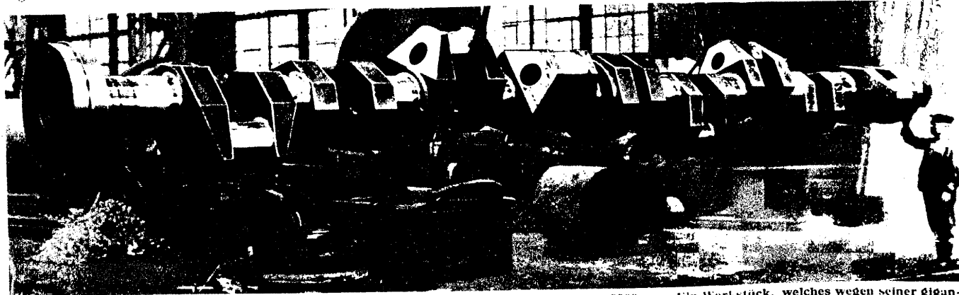
Neunfach gekröpfte, geschmiedete Kruppsche Kurbelwelle für einen Schiffsdieselmotor, Länge 9500 mm. Ein Werkstück, welches wegen seiner gigantischen Abmessungen und wegen seiner höchsten Präzision allgemein bewundert wurde. Geniale Konstruktion und Berechnung, die Beherrschung schwierigster Beanspruchungen, zuverlässiges Material, höchste Schmiede- und Bearbeitungskunst sind in diesem Schaustück vereint.
