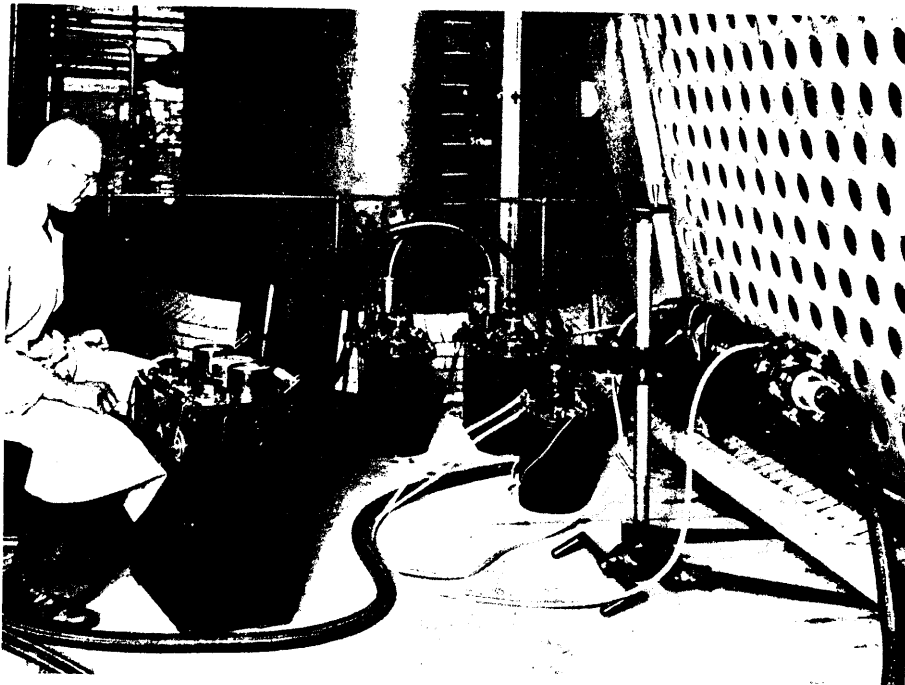
Abb. 40 Untersuchung eines Dampfkessels mit Röntgenstrahlen
