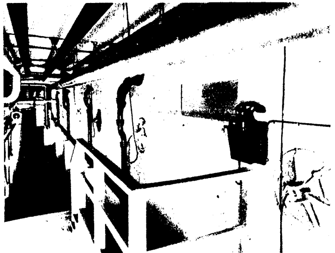
Abb. 2 Blick in den Zugangsschacht zu den Unterwasserleuchten im Haus des Deutschen Sports. Im Vordergrund der Unterwasserbeobachtungsstand
