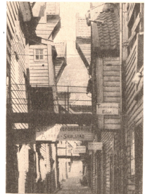
Speichergasse im Hanseviertel zu Bergen
