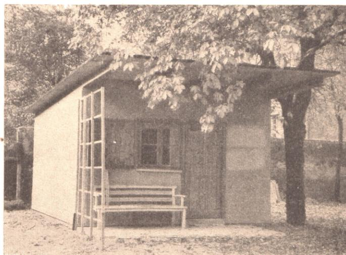
Bild 1 Beispiel eines Behelfsheimes nach Bild 2b, ausgeführt von der Deutschen Bau A. G. im September 1943 in Stahlbeton-Gerippebau und Betondach mit Dachsparren aus Stahlsaitenbeton und Bimsbetonstegdielen
