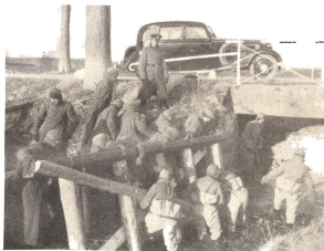
So erhöht man die Tragfähigkeit einer Brücke
