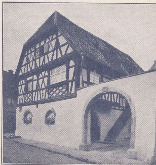
Der Bau vor und nach der Wiederherstellung
