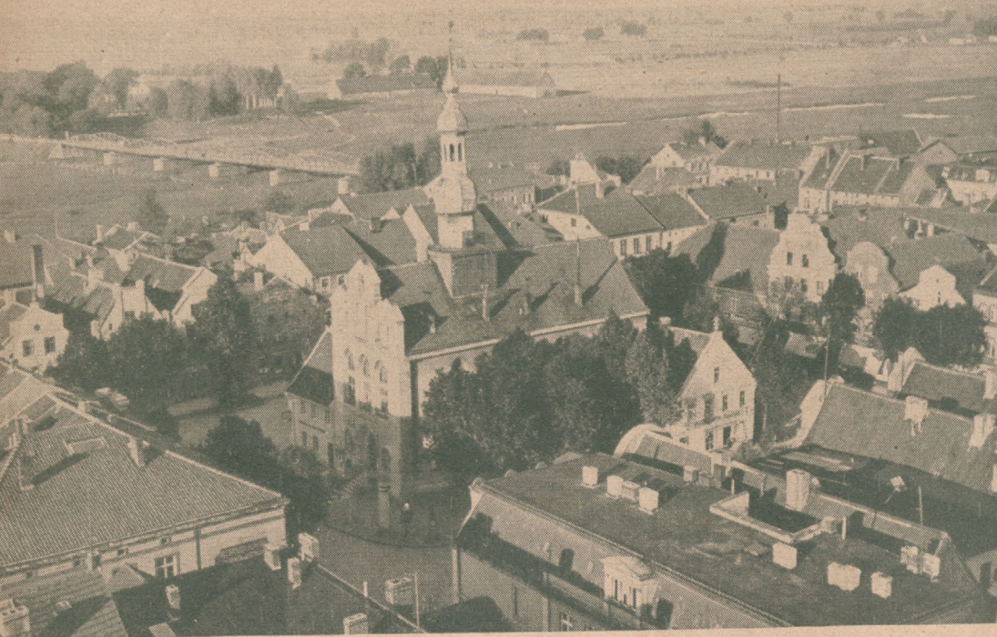
Blick auf Rathaus und Markt vom Turm der Stadtkirche.
