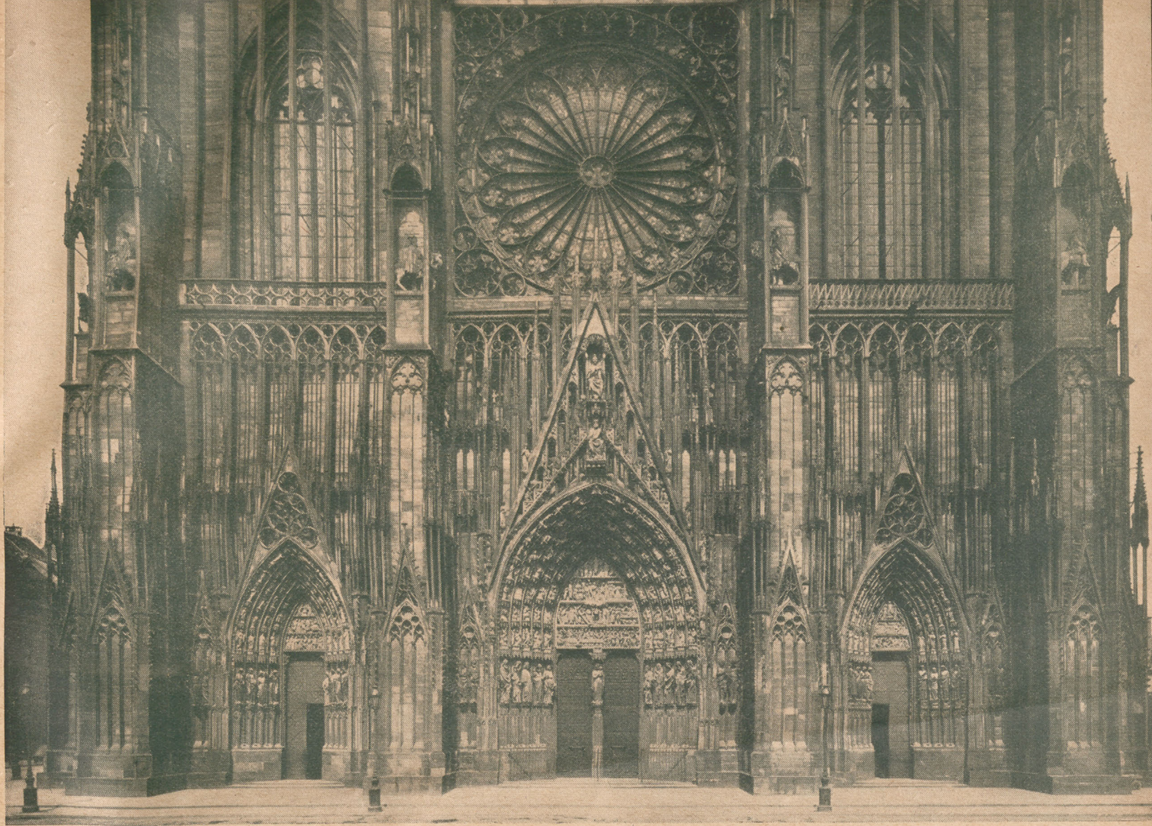
Hauptportal an der Westfassade des Straßburger Münsters (1310—1320).
