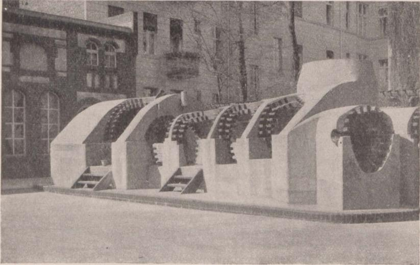
Bild 6. Zusammenführung zweier gemauerter Kanäle mit Einsteigeschacht. Nachbildung in natürlicher Größe auf dem Hof des Museums der Stadtentwässerung in Berlin
