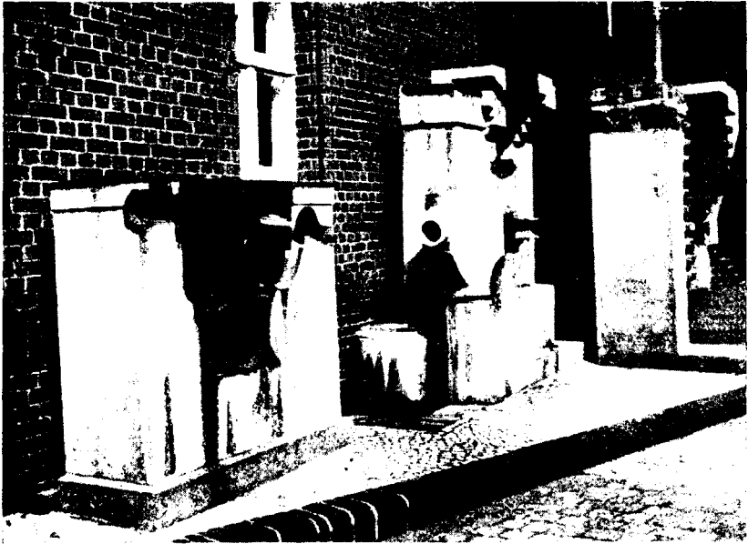
Bild 8. Benzinabscheider und Regeneinlässe. Nachbildungen in natürlicher Größe auf dem Hof des Museums der Stadtentwässerung in Berlin
