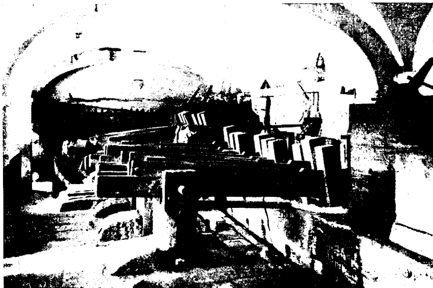
Bild 3. Hadernstampfwerk nach mittelalterlicher Art in einer italienischen Papierfabrik
