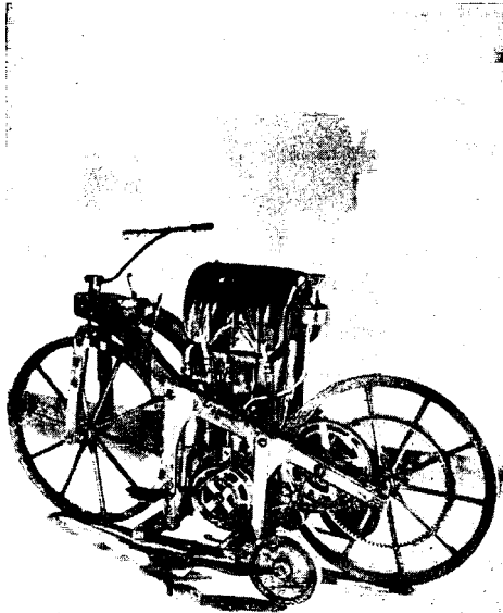
Abb. 3. Erste Anwendung des schnelllaufenden Daimler-Motors in einem Daimler-Kraftrad 1885. Leistung 1/2 PS, Geschwindigkeit 12 km/h
