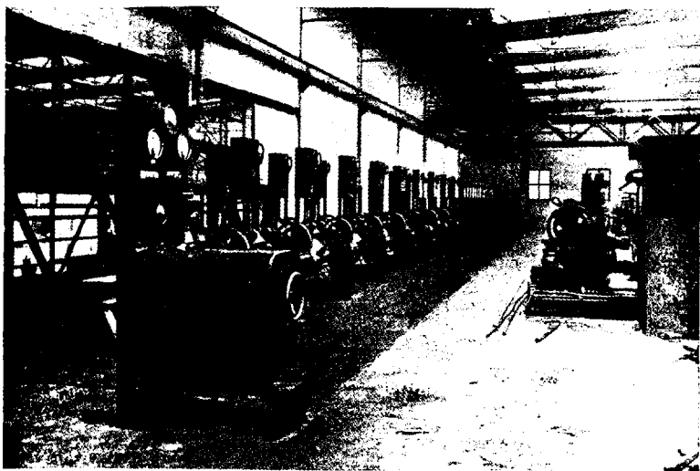
Abb. 21. 41 gerüstiges Walzwerk
