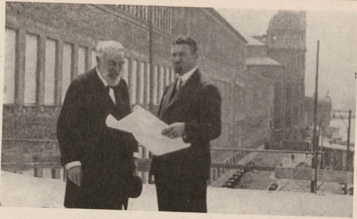
Abb. 11. Oskar von Miller auf der Baustelle des Studienbaues mit Architekt Bäßler
