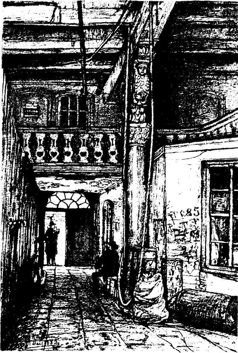
Riefesell: Diele im Neuen Wandrahm 92 (später 15/16) (Schopenhauer-Wohnhaus in Hamburg)
