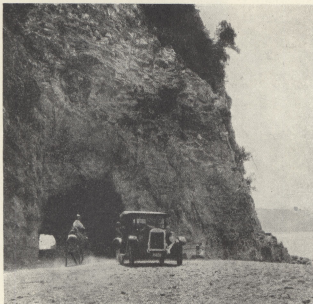
Tunel drogowy w Albanii.
