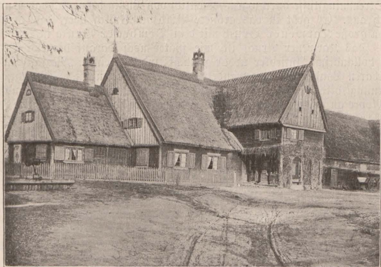
Charakteristisches Holzgebäude aus der Culmer Stadtniederung.
