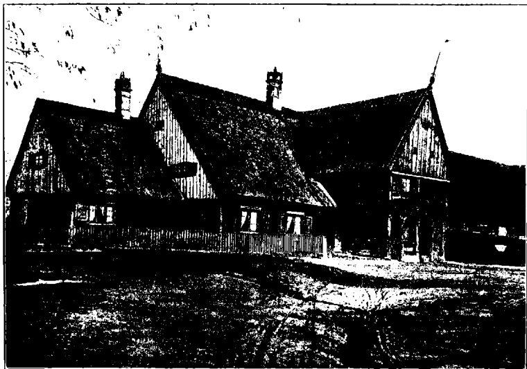
Charakteristisches Holzgebäude aus der Culmer Stadtniederung.
