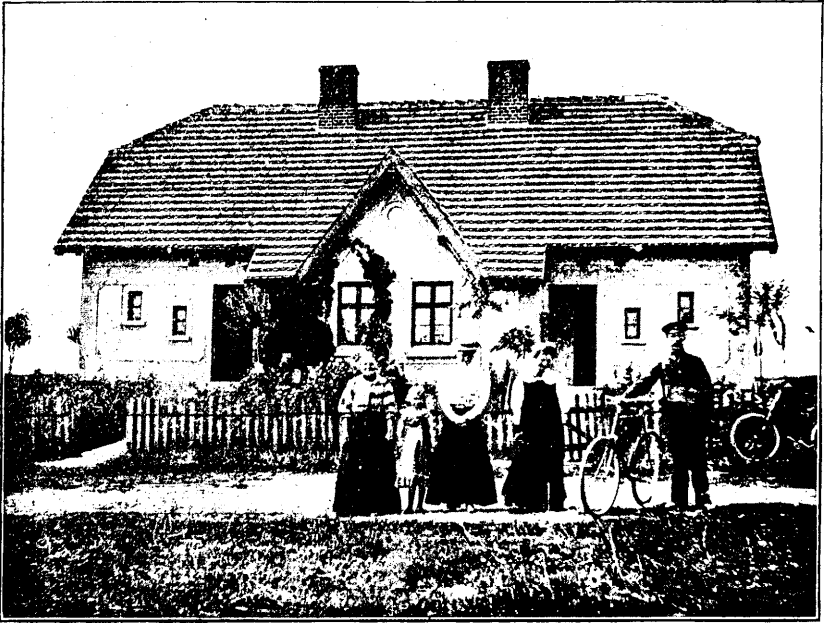
Arbeiter-Mietshaus in der Ansiedelungsgemeinde Neu-Waldau, zugleich Station der Diakonisse in der Kirchengemeinde Gross-Lossburg.
