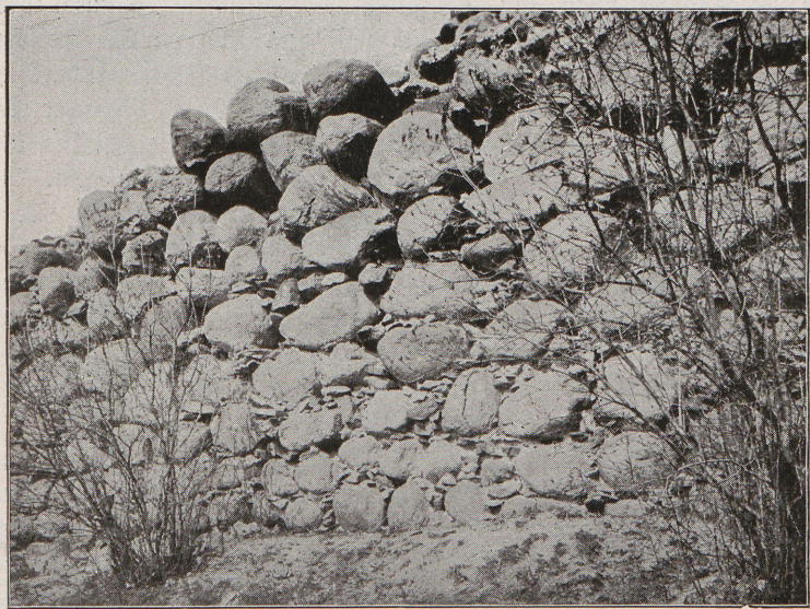
Mauerteile der Burgruine Schlochau, aus sorgfältig geschichteten Granitblöcken
