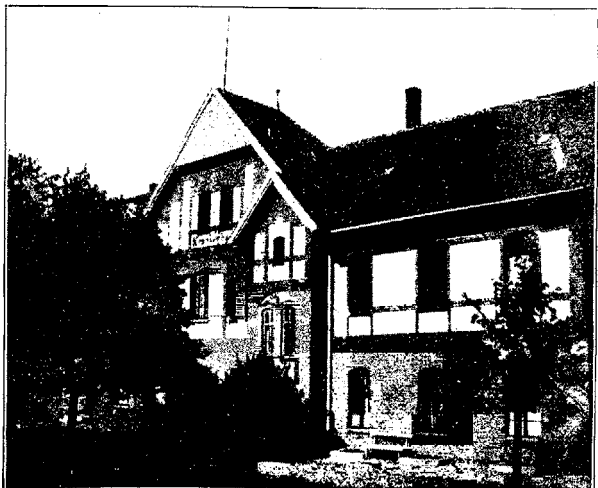
Krankenhaus in Kraxtepelln.
