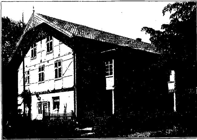
Das Gemeindehaus in Neukuhren. Ehemaliges Douglas'sches Gebäude.
