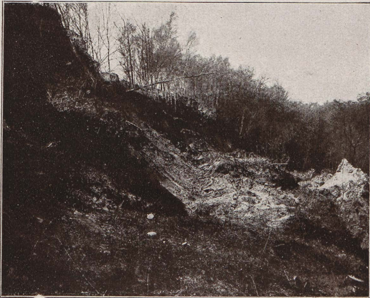
Abgerutschte Uferstrecke an der Steilküste.
