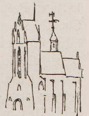
Dachreiter der Kirche vor dem Abbruch. Nach Giese.
