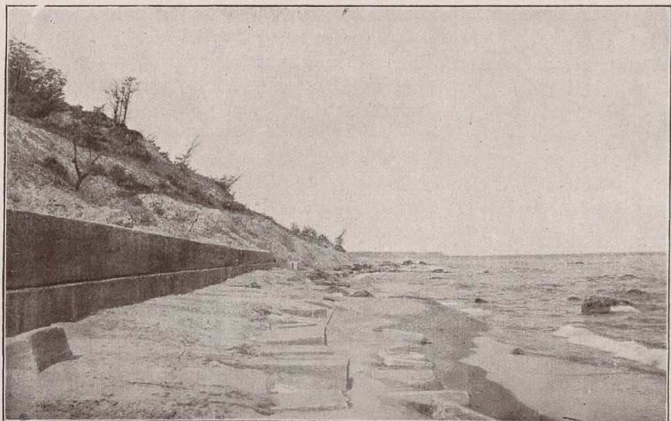
Uferschutzmauer westlich der Wolfsschlucht bei Warnicken. 1920.
