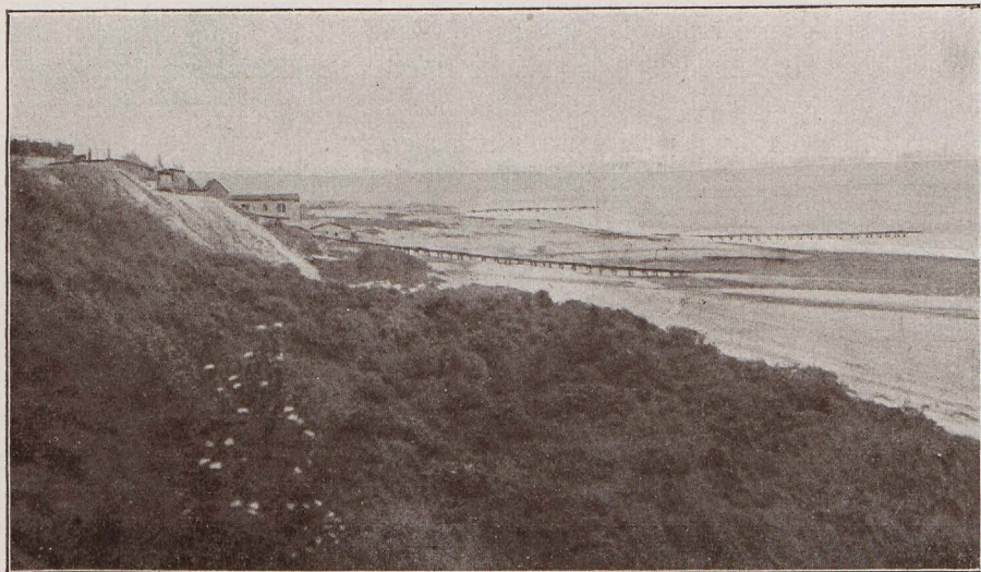
Ausgeschlämmte Erdmassen des Tagbaues.
