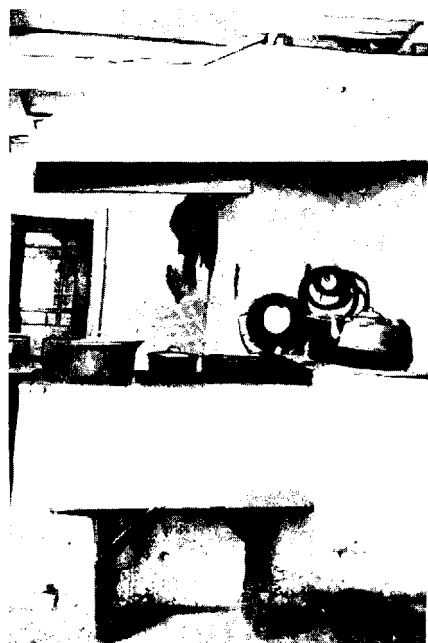
Abb. 51. Umgebaute Küche, Kallenzinnen, Kreis Johannisburg.
