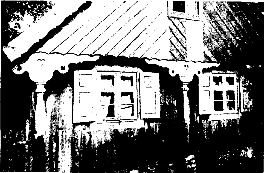
Abb. 63. Giebellaube am dreigeteilten Haus zu Liebenberg, Kr. Ortelsburg.
