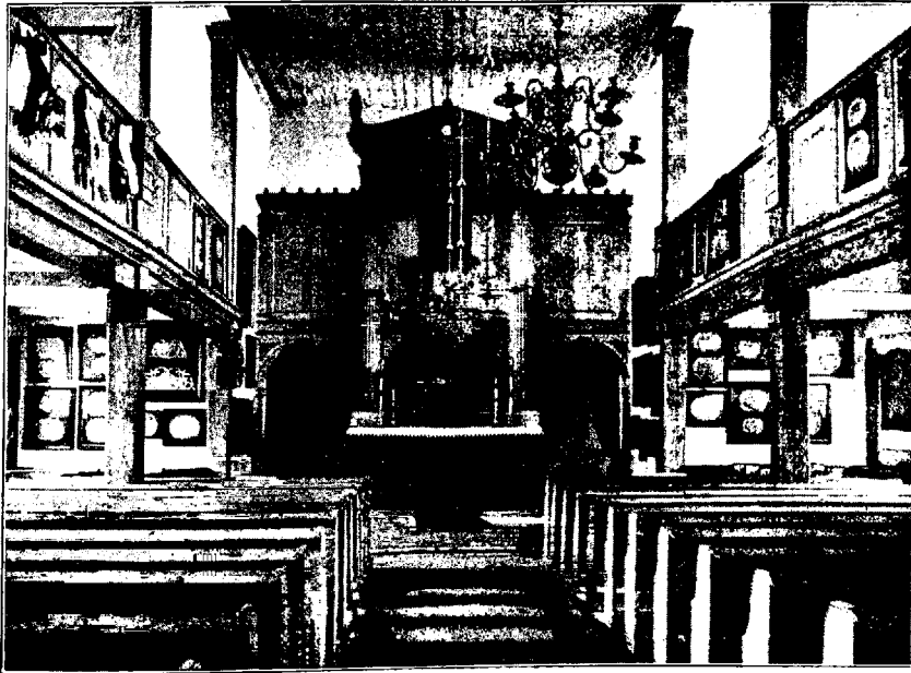
[Abb. 185. Evangelische Kirche in Groß-Lichtenau, Innenansicht.
