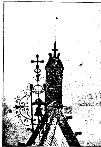
Abb. 210. Glockengerüst auf dem Dach der katholischen Kirche in Marienau.
