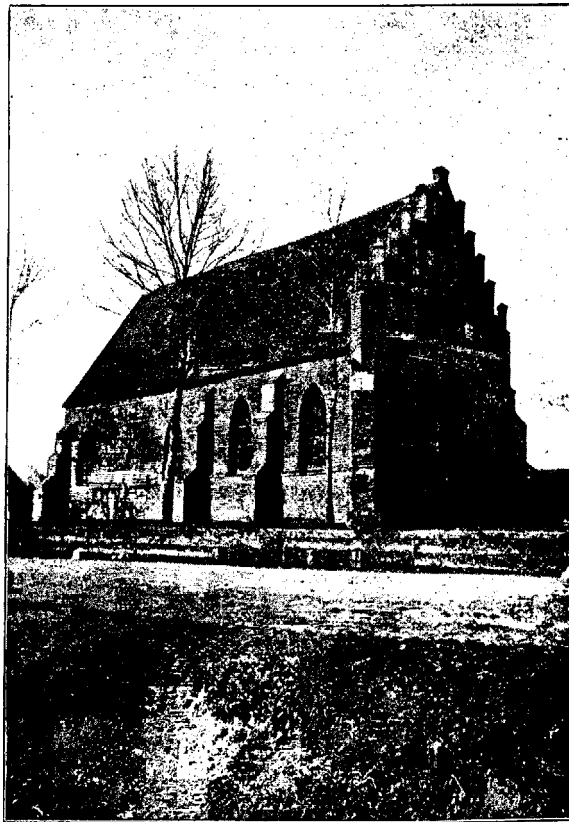
Abb. 40. Nordostansicht der kath. Kirche zu Bärwalde.
