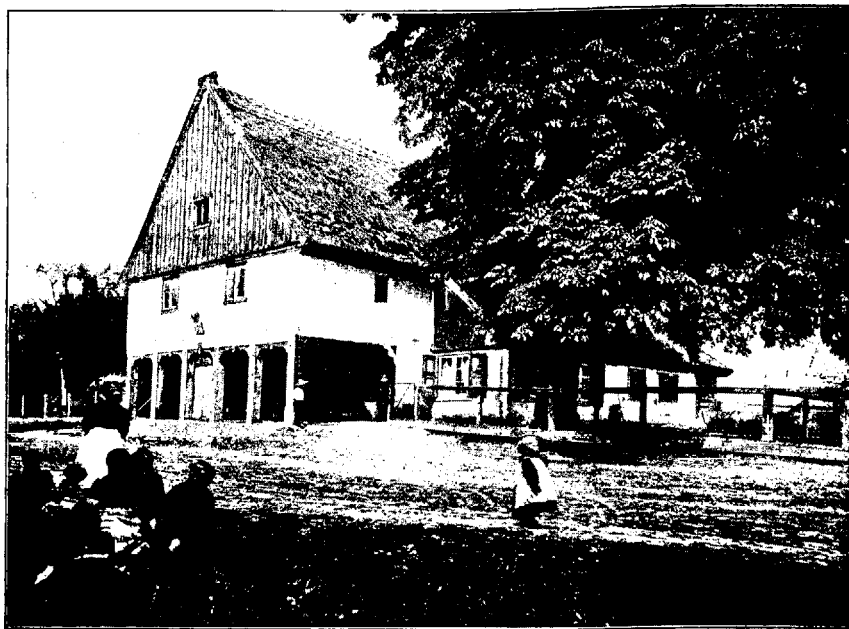
Abb. 50. Haus Nr. 4A in Blumstein vor dem Abbruch der Vorlaube.
