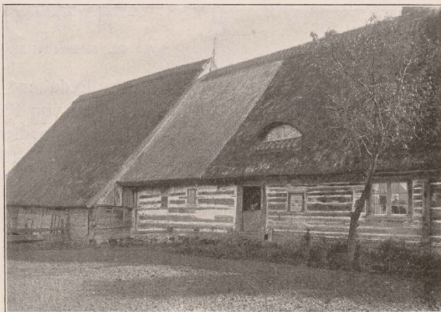
Abb. 96. Haus Gorundzielski in Montauerweide. Feldseite.
