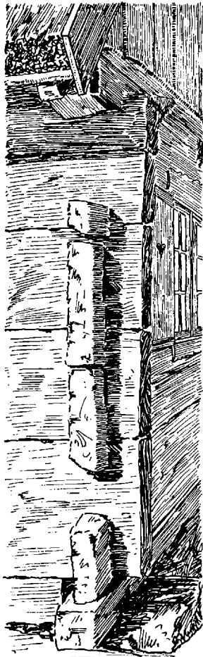
Fig. 7. Bohlwanddeckung in Luxethen, Kreis Pr. Holland.
