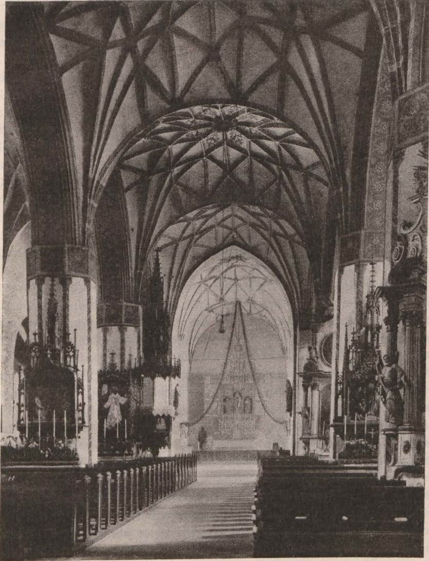
Abb. 24. Pfarrkirche zu Wartenburg, Mittelschiff n. Osten.
