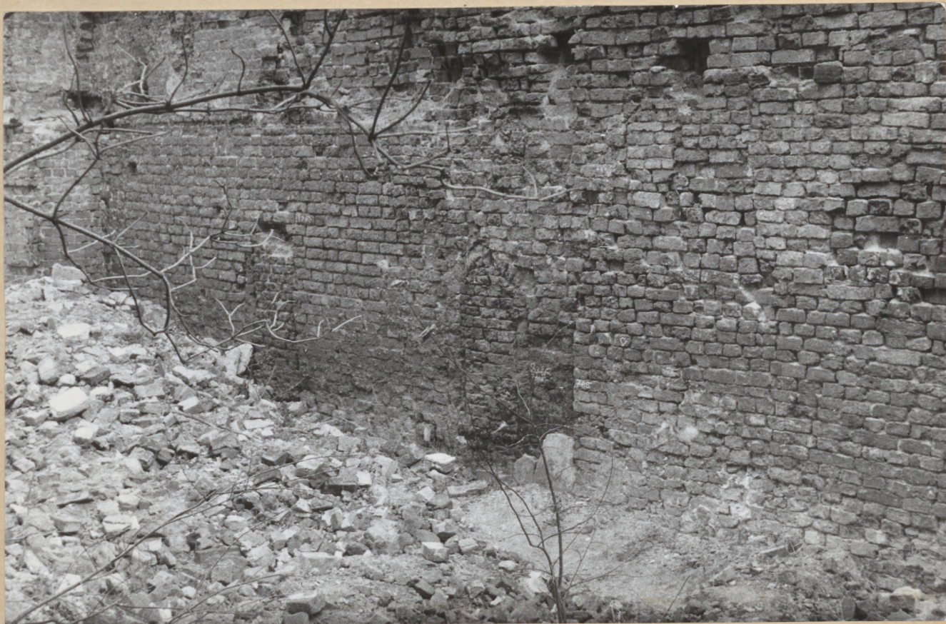
27. Kamieniczka nr 2. Przyziemie ściany wschodniej.
