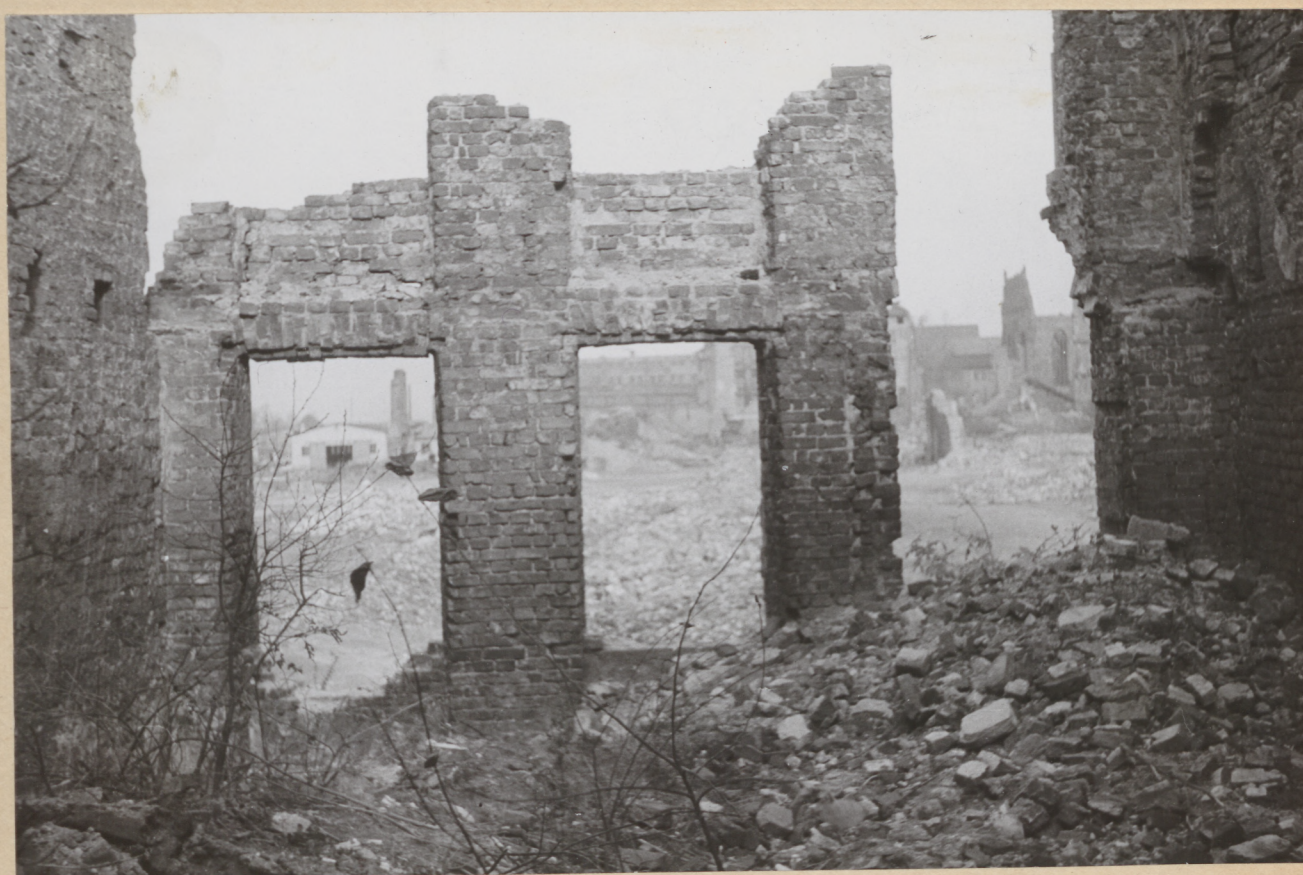
21. Kamieniczka nr 2. Resztkę elewacji frontowej od strony wnętrza.
