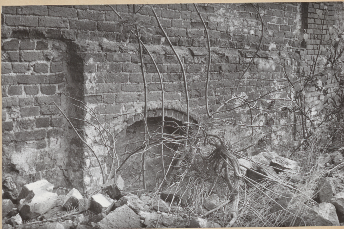
16. Kamieniczka nr 3. Fragment zachodniej ściany przy- budówki.
