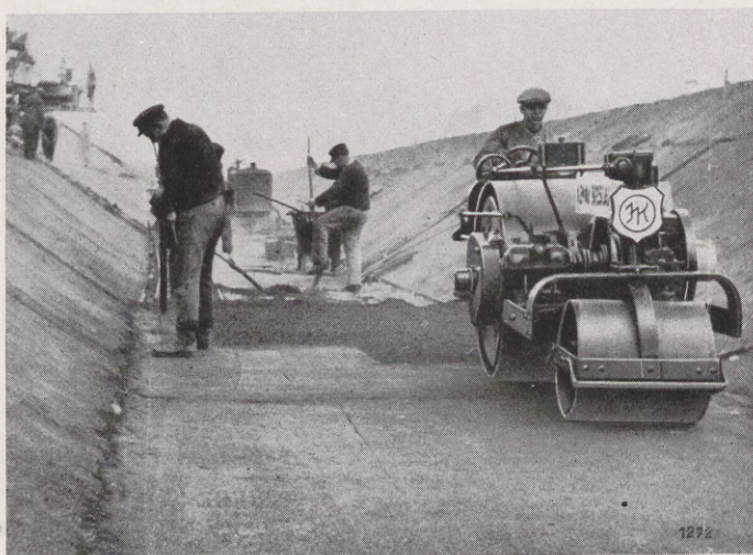
zum Bau von Kanalsohlen
