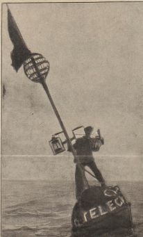
Befestigung der Laternen an der Boje
