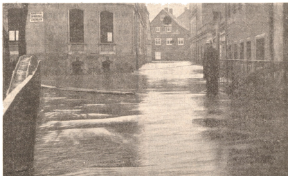
Überflutung in Grassitz (Gassenmühle und Brücke) 4. Januar 1932.
